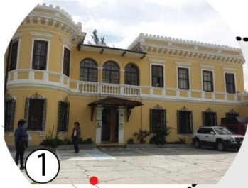
EDIFICIO DE FACULTAD DE CIENCIAS ADMINISTRATIVAS
