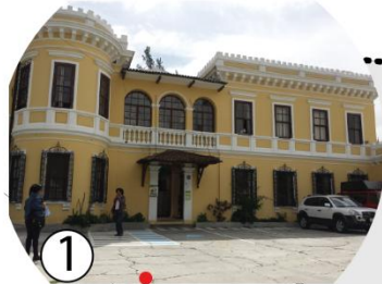
EDIFICIO DE FACULTAD DE CIENCIAS ADMINISTRATIVAS
