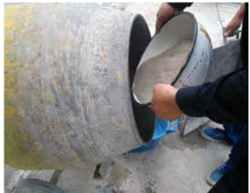
Figura 13. Agregar la arena
