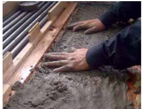
Figura 18. Colocación de la malla
