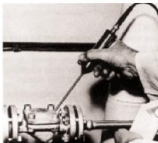
Figura 4. Revisión ultrasónica de trampas de vapor. (Fuente: [8])
