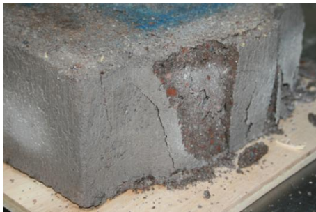
Figura 13. Plano de fractura de un adoquín con vidrio fino ensayado a compresión.
