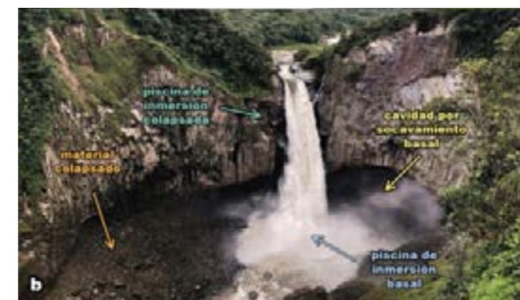
Figura 1. a) Morfología de la cascada de San Rafael, previo al evento del 2014, mostrando la estratigrafía general con el dique de lava y los sedimentos subyacentes, además de la piscina de inmersión intermedia socavada por perforación vertical y la zona de erosión basal; b) Morfología de la cascada de San Rafael posterior al colapso de 2014, mostrando una gran cavidad formada por la piscina de inmersión basal; c) zona de baipás y puente de lava remanente que soportaba la cascada de San Rafael. Modificado de Reyes et al. (2021).
